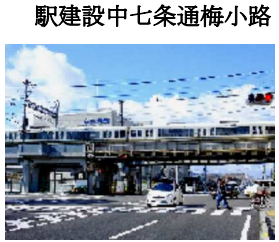
駅建設中七条通梅小路
