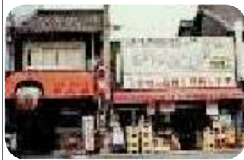
③ 昭和53年: 父一郎が亡くなり、相続した現在地をビルに建替へ。1階をファミマ・2階に「めん坊」を入れたが、後「集西菜」にした。
